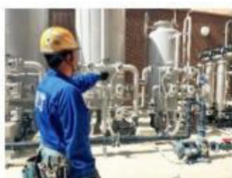
貯水槽設備の点検の様子
